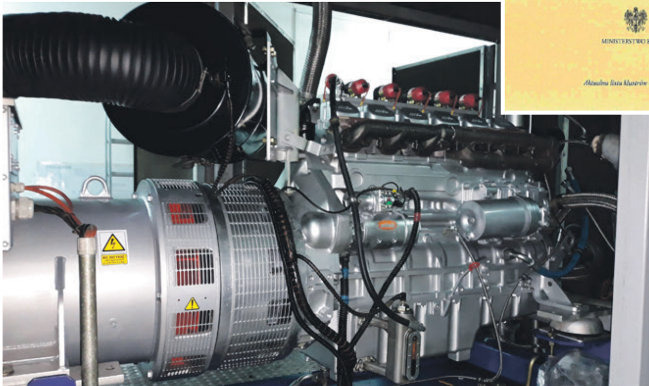
■ Montaż modułu kogeneracyjnego po remoncie
