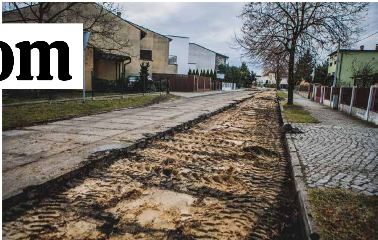
■ Również odcinek ulicy Kilińskiego (pół kilometra) przejdzie gruntowną modernizację
