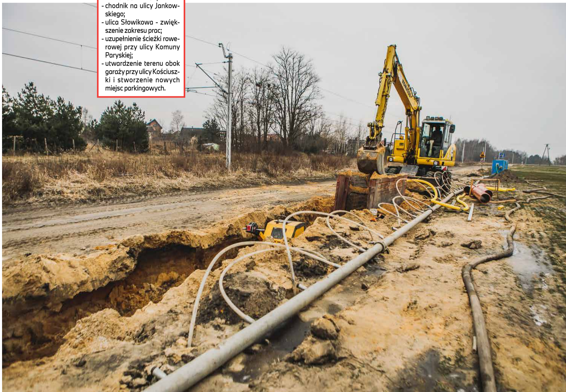
■ Zakończenie prac przy ulicy Krawcowej planowane jest na czerwiec 2025 roku
