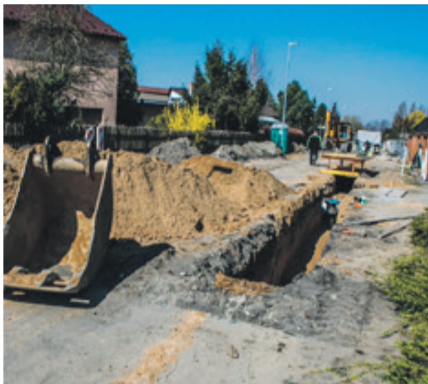
■ Rozpoczęły się prace przy budowie nawierzchni ciągu pieszo-jezdnego oraz kanalizacji deszczowej na ulicy Wilieńskiej
