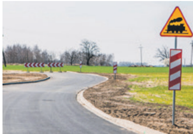
■ Zakończyła się natomiast przebudowa ponad 300-metrowego odcinka ulicy Krańcówej na osiedlu Zębów.
