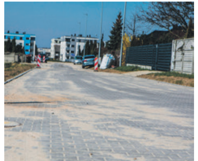
■ Kontynuowane są prace na ulicy Słowikowej
