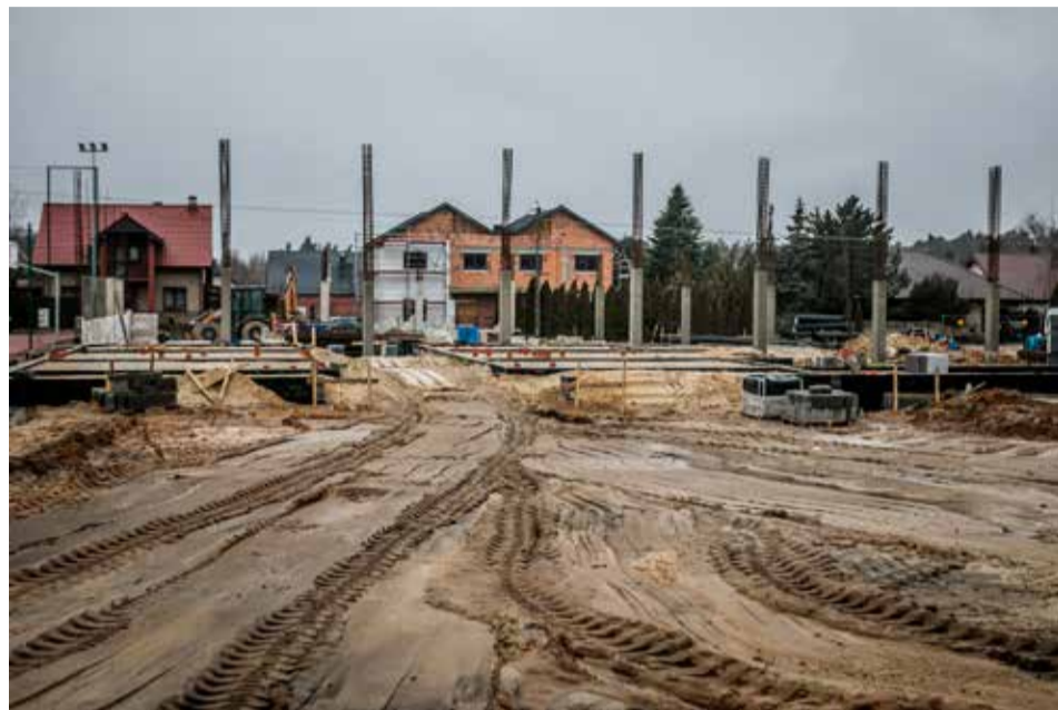
Budowa hali sportowej przy Szkole Podstawowej nr 13 już trwa
